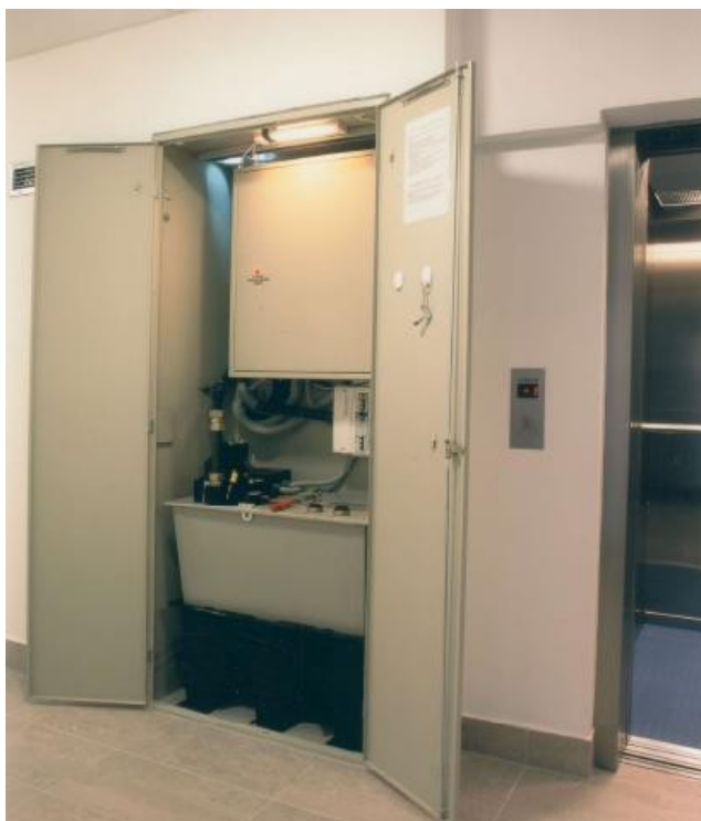
Dźwig hydrauliczny z maszynownią prefabrykowaną foto. Sursum sp. z o.o. (archiwum)
