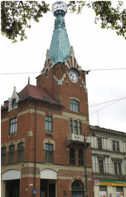
Fot. 1 Widok budynku od strony Rynku z ul. Sławkowskiej
